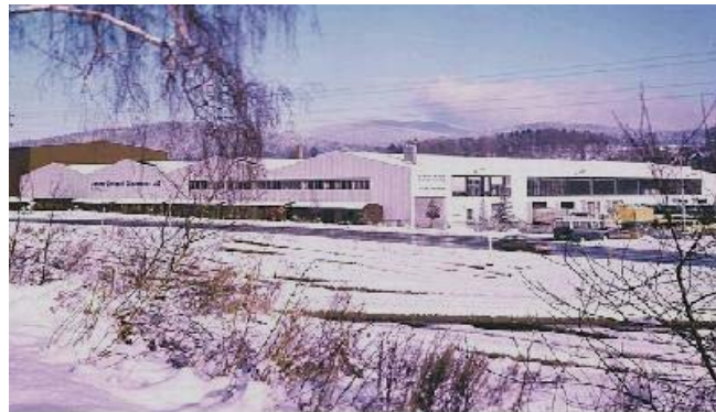
Logistikzentrum in Zwiesel
